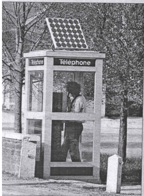
Photo 1 • Cabine téléphonique surmontée d'une batterie photopiles.
